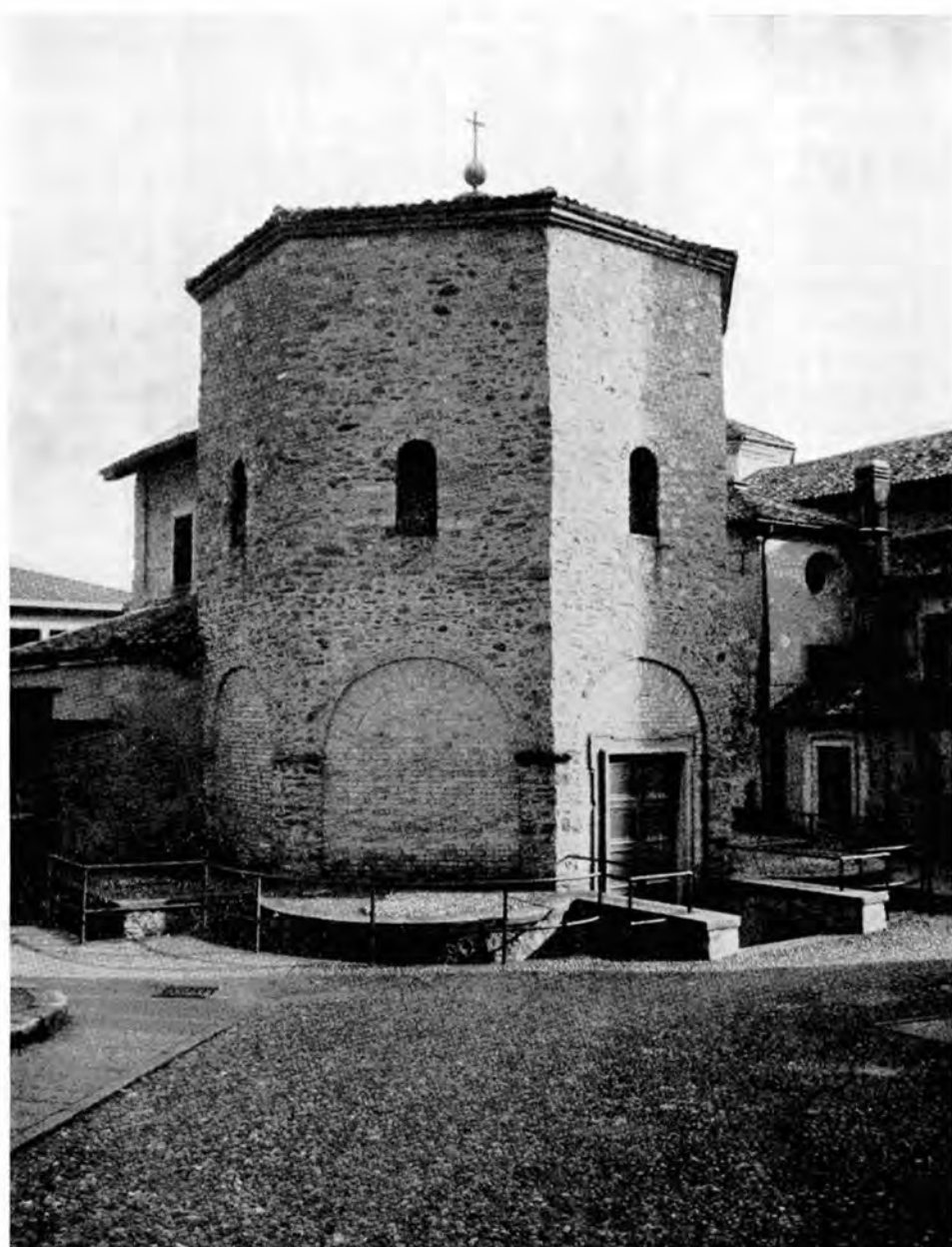
Fig. 1 - Lati Nord, Nord-ovest e Ovest del battistero di Arcisate. La finestrella occidentale fu rifatta durante i restauri del 1936-38. L'edificio, nonostante l'abbattimento delle nicchie, non presenta lesioni. In ottime condizioni statiche era descritto nel 1597 (ACM, Arcisate 27, q. 3).
