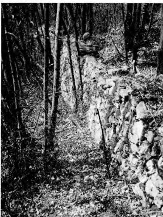
Foto 10 - La muraglia che collega l'ingresso S-E con l'organismo N-E.
