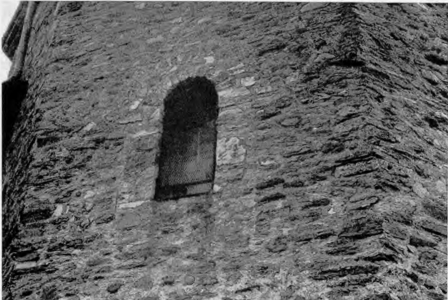
Fig. 3 - Lato Nord. Sono nettamente visibili ai lati della finestrella altomedioevale le spalle di quella originaria.
