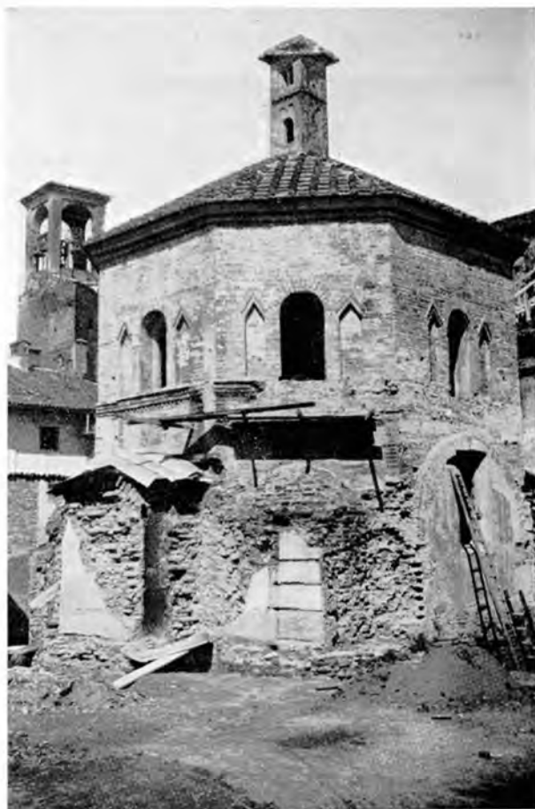
Fig. 13 - Il battistero di Lomello durante i lavori di restauro. Anche qui le absidioline erano coperte da volte. (Foto Stefano Cattaneo)
